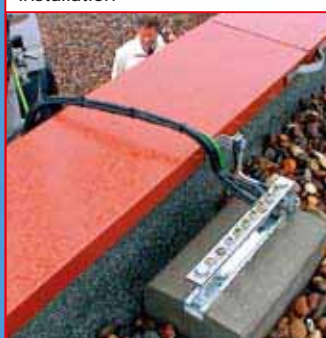
安装于屋顶的等电位连接排 Equipotential bonding at a rooftop installation
