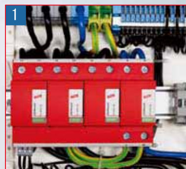
安装在配电柜中的DEHNventil® modular DEHNventil® modular in a power supply cabinet
