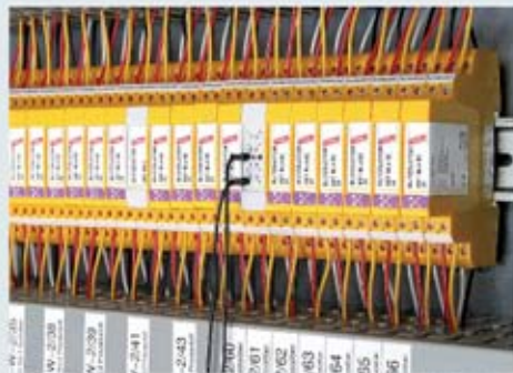
应用于信息系统的可插拔的通用多线雷电流和电涌保护器。使用便携读取设备或固定监测装置可无接触地、快速地测试内置LifeCheck功能的SPD模块。
